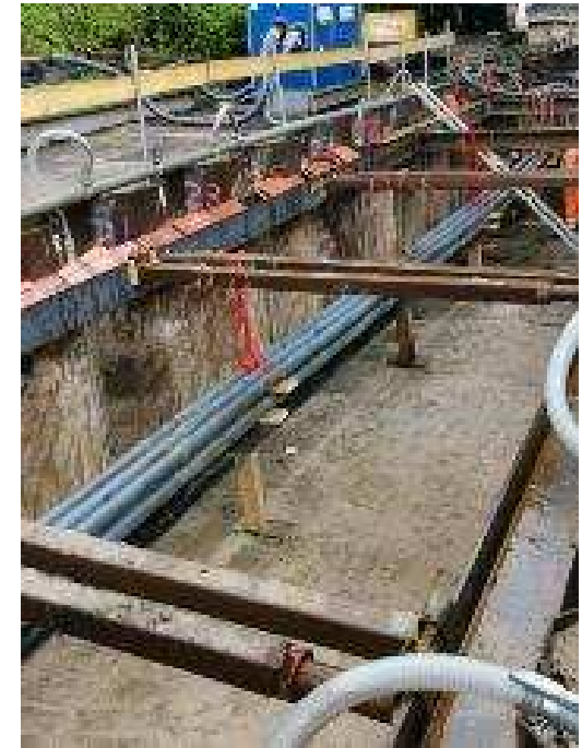
Kabelgraben mit Hochspannungskabel
