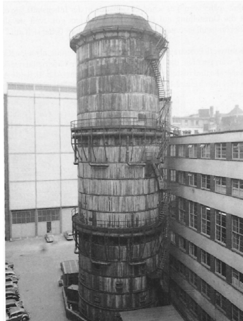
Abbildung 25: Ehemaliger Heißwasserspeicher der HEW-Fernwärme am Gerhart-Hauptmann-Platz (1926), aus 101
