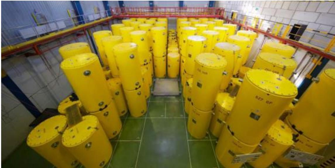
**Abbildung 2: 152 beladene CASTOR®THTR/AVR-Behälter im AVR-Behälterlager**
